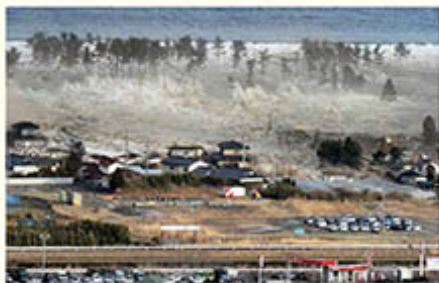
東北地方太平洋沖地震による津波の被害
