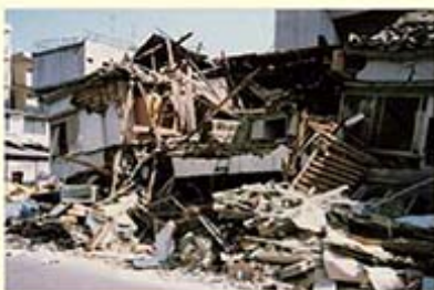
阪神・淡路大震災での住居の被害の様子 出典：一般財団法人防災科学総合センターHP
