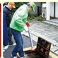
② 消火栓に差し込む
