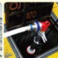
③ スタンドパイプとホースをつなぐ
